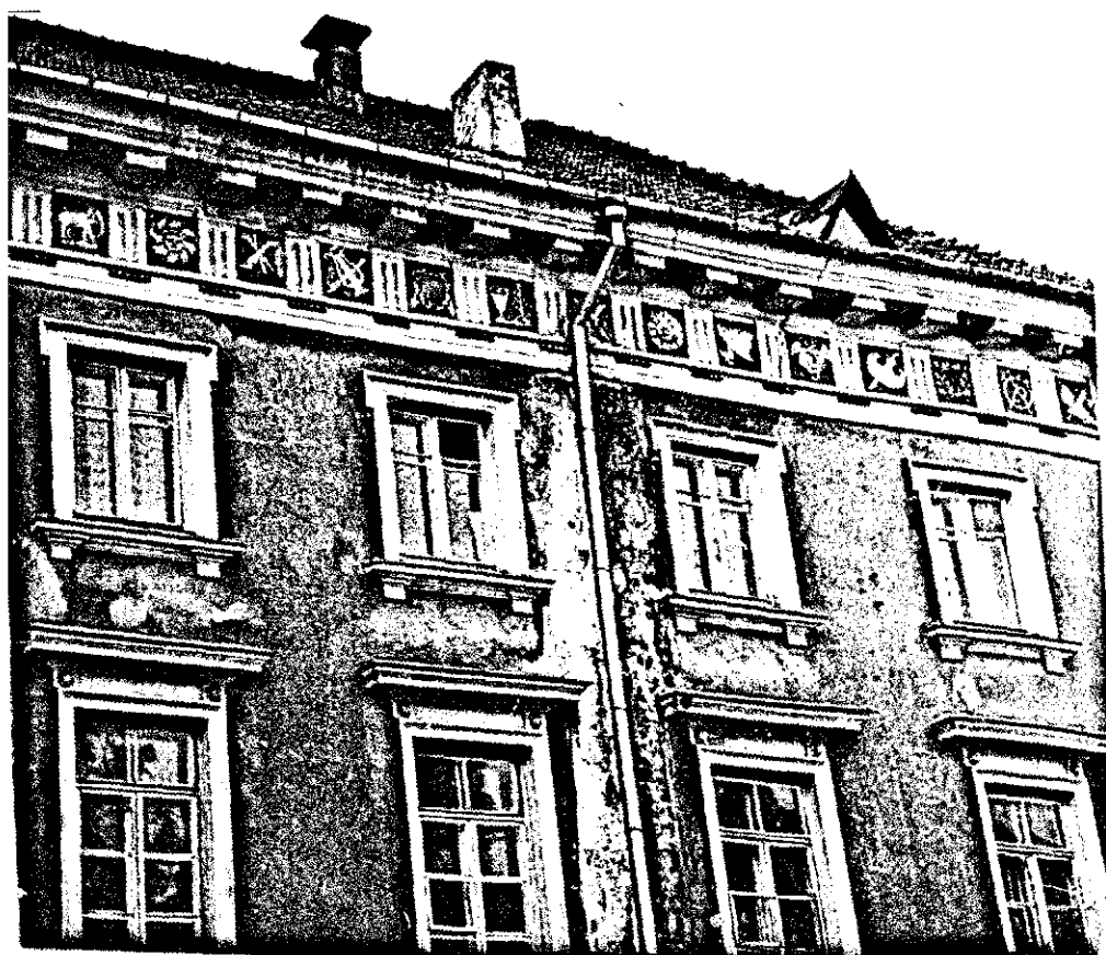
Rūmų Trakų I7 (buv. Tyzenhauzų) fasadas iš Muziejaus gatvės pusės
